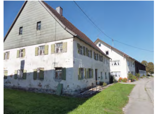
Abb.: 069: Schlechter Zustand ortsbildprägender Gebäude
