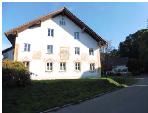
Abb.: 050: Ortsbildprägende Gebäude, Heimenegger Weg
